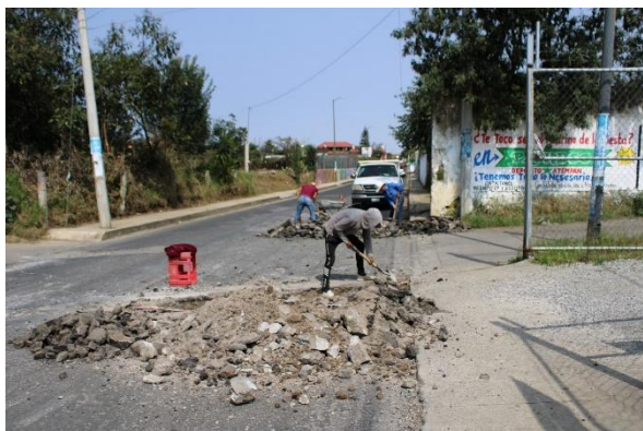
Rompiendo piso a reparar tramo gasero el Carmen
