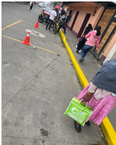
Pintada de guarniciones en calle 16 de septiembre
