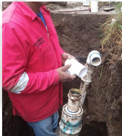
Reparación en red de agua calle 8 sur esquina 7 oriente.
