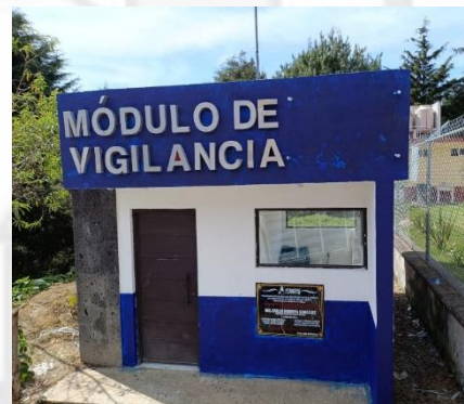
Caseta de Cala Norte
