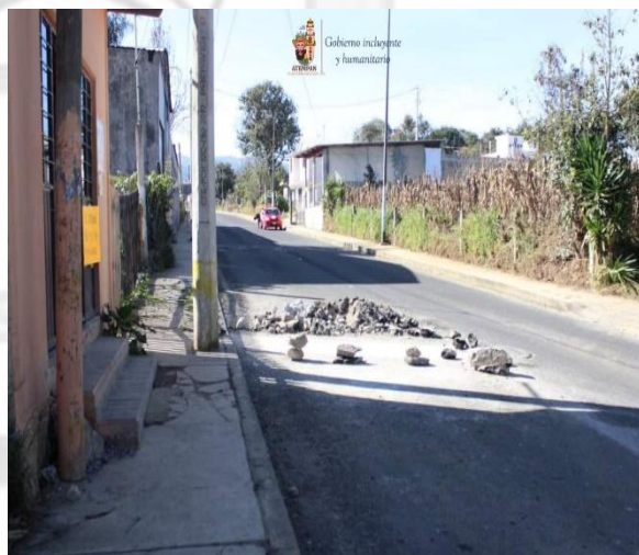
Piso reparado, tramo Tezhuatpec - el Carmen
